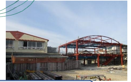
鉄骨から新園舎の形がわかるようになりました。
