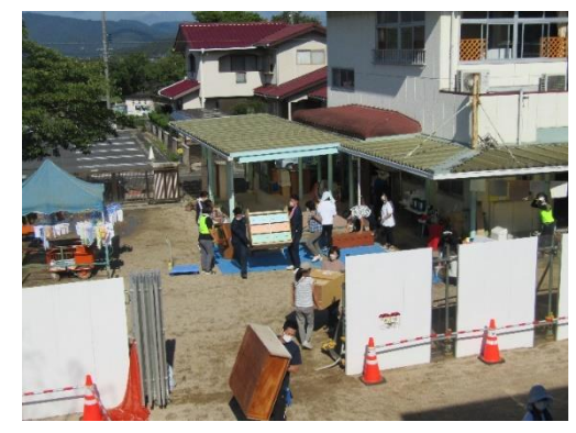
令和3年8月28日 1期工事が終了し、工事の方、他園の職員にも力を借り、大引越しをしました。
